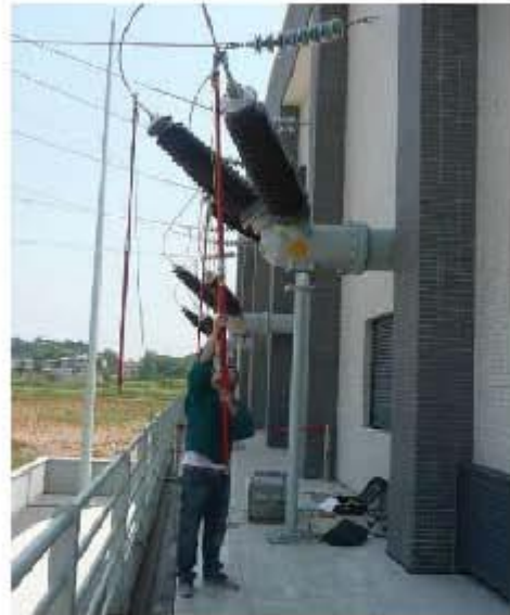
图 6-1：拆掉接地棒地线 图 6-2：测试线通过绝缘棒引到被测线路上
